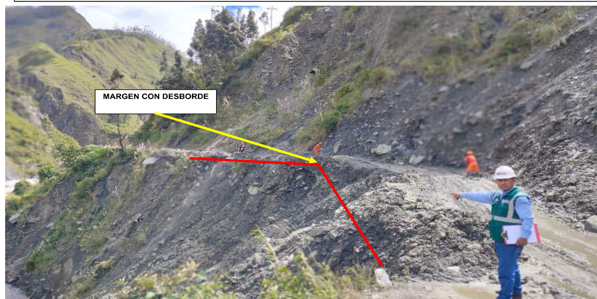
FIGURA N° 02: SOCAVAMIENTO DE CARRETERA QUE VA AL DISTRITO DE ALTO INAMBARI Y DISTRITO DE YANAHUAYA.
