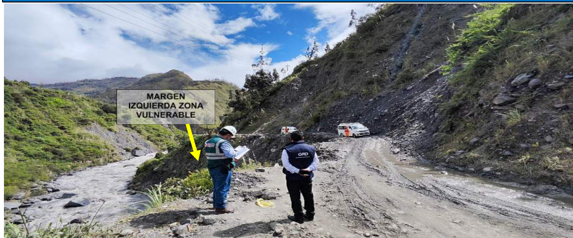
FIGURA N° 01: SOCAVAMIENTO DE CARRETERA QUE VA AL DISTRITO DE ALTO INAMBARI Y DISTRITO DE YANAHUAYA.
